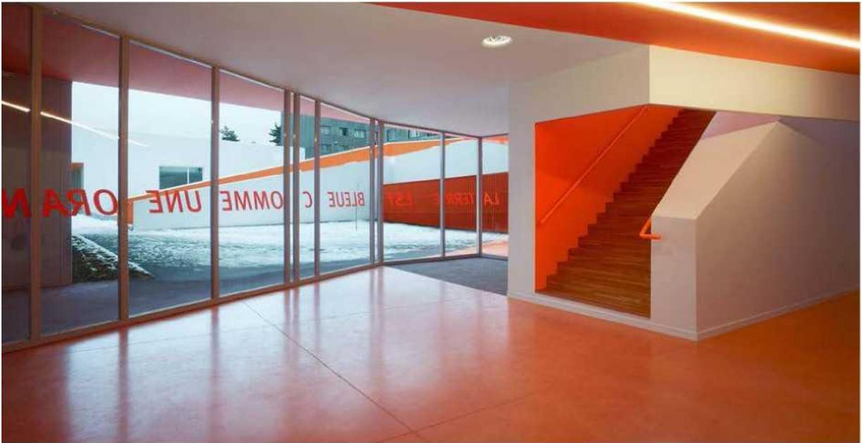
рисунок 23 «Монолитный бетонный пол обладает высоким коэффициентом трения и показателем износостойкости, безопасен и прост в уборке. Дополнительно устроены швы, препятствующие деформации покрытия от перепадов температуры и влажности».
